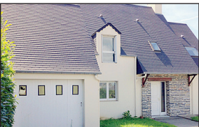
Plein centre du bourg de Les Pieux
